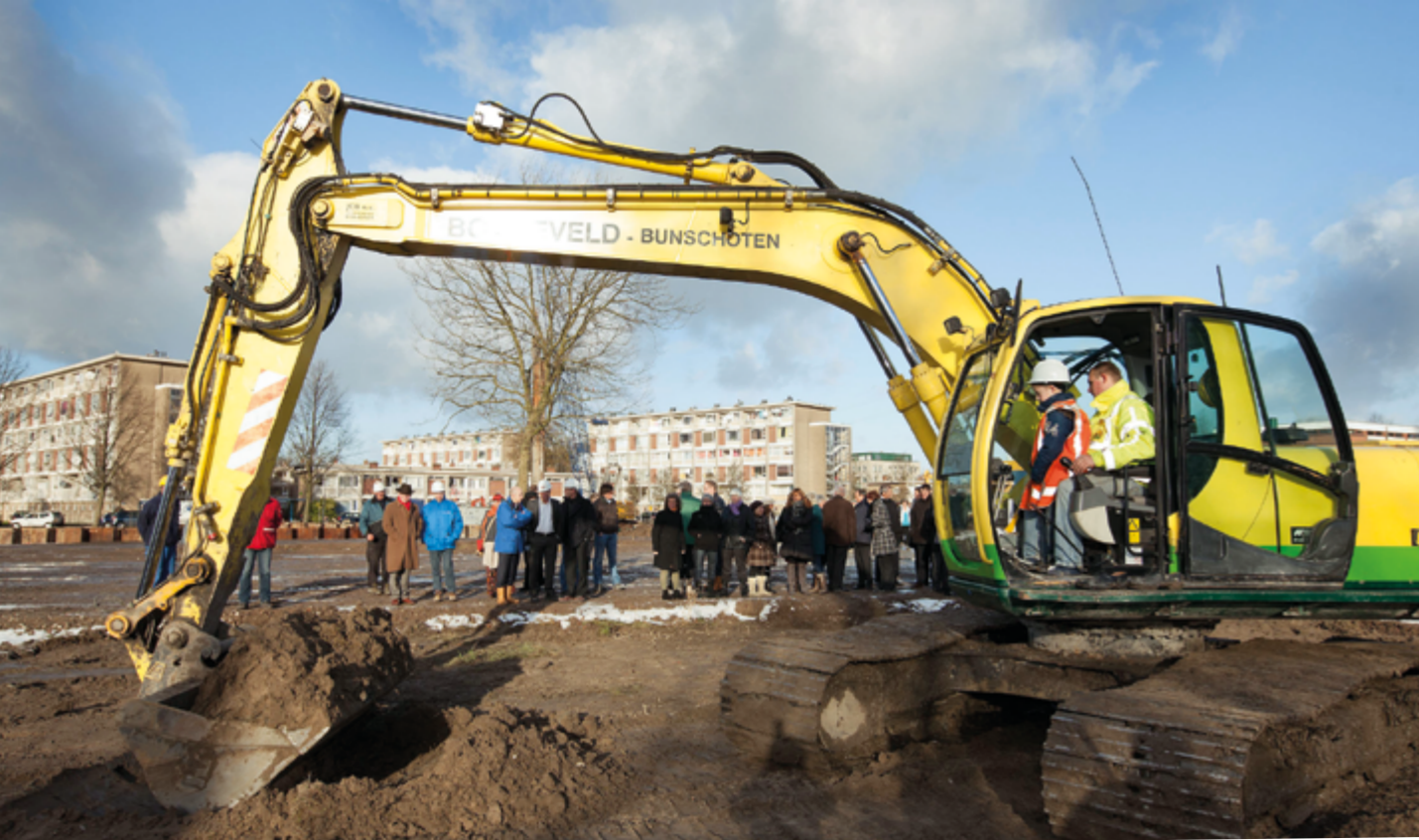
Startbouw brede school Het Gebouw
